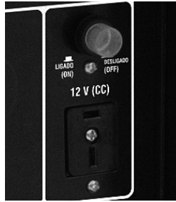
Figura 15 – Disyuntor del circuito CC
