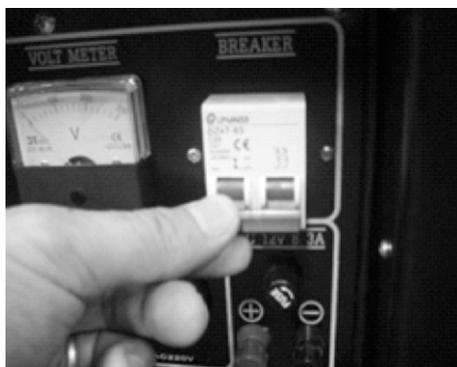
07. Para desligar o gerador é necessário desligar o disjuntor do painel colocando na posição "OFF" conforme indicado, com a haste para baixo, o gerador não deve ser desligado com os aparelhos conectados, pode ocorrer à queima destes equipamentos.
